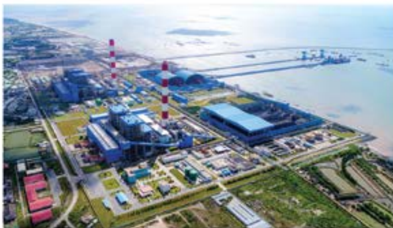
▲ Toàn cảnh Nhà máy Nhiệt Điện Duyên Hải
